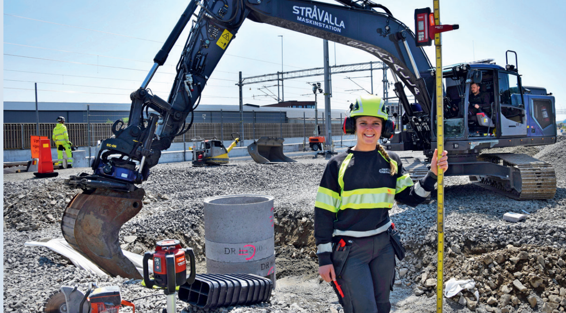
Alice Modelius jobbar för Martin Grävare på projektet med Varbergstunneln. Här är Rikard Sandersson, som kör för Stråvalla maskinstation och Alice igång med att återställa den gamla bangården.
